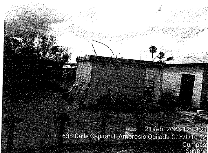
CUARTO-DORMITORIO A NIVEL DE CADENA DE CERRAMIENTO Y OTRO SIN FIRME.
